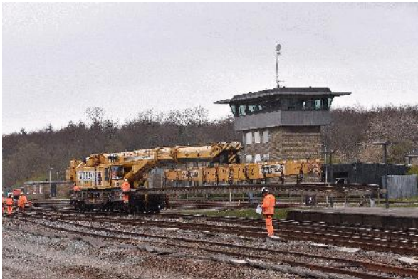
Kranen kører med endnu en sporramme.
