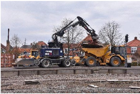
I spor 0 fjernes svellerne. PU-signalet var vist det eneste, der var tilbage i Nf!
