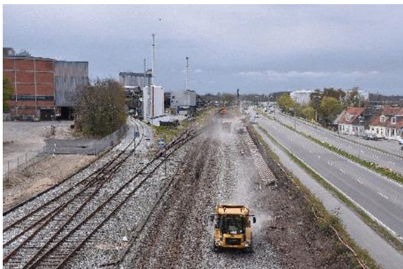
Også længere sydpå arbejdes der.
