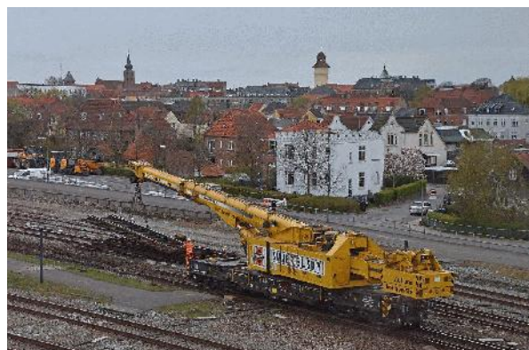
Kranen løfter et sporskifte uden åg. Sporskiftet var skåret i tre dele. Nf's "skyline" i baggrunden.
