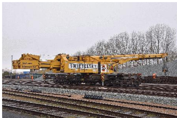
Kranen lægger sporskiftet af.
