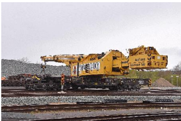
Kranen lægger sporskiftet af.
