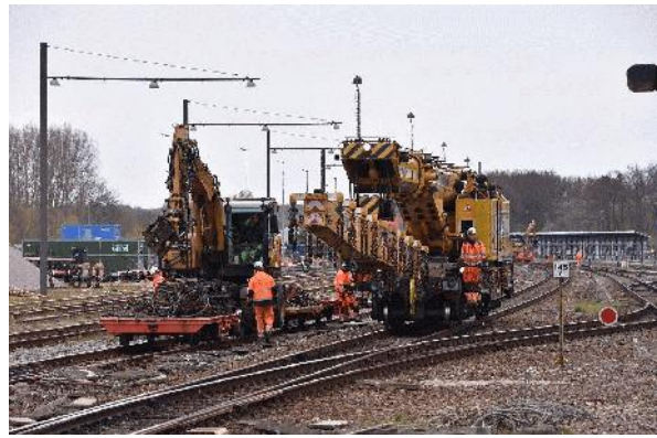
Kranen ved siden af et af de hold, der flæede alle kabler op.
